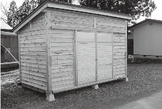
木造（町産木材使用）幅3.6m×奥行1.8m×高さ1.9m（約2坪程度）
