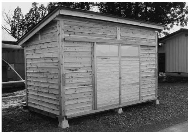
木造（町産木材使用）幅3.6m×奥行1.8m×高さ1.9m（約2坪程度）
