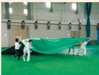
土足で入場できるように、室内をビニールシートで覆い隠す作業
