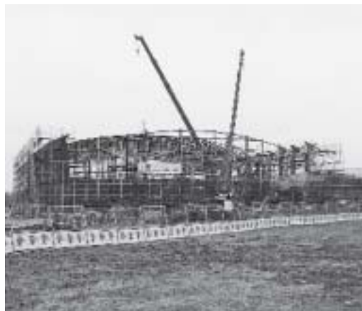
建築工事が進む勤労者総合スポーツ施設
