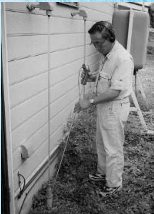
宅地内での漏水調査
