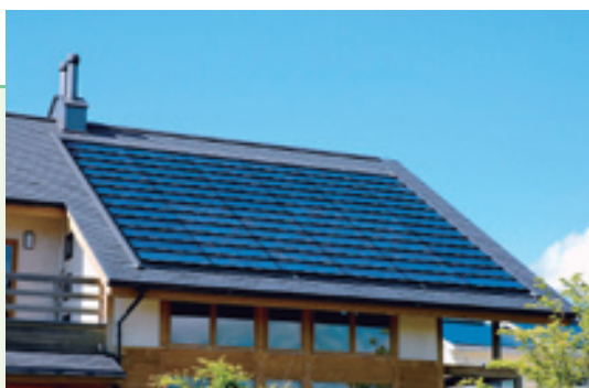
【太陽光発電設備】
