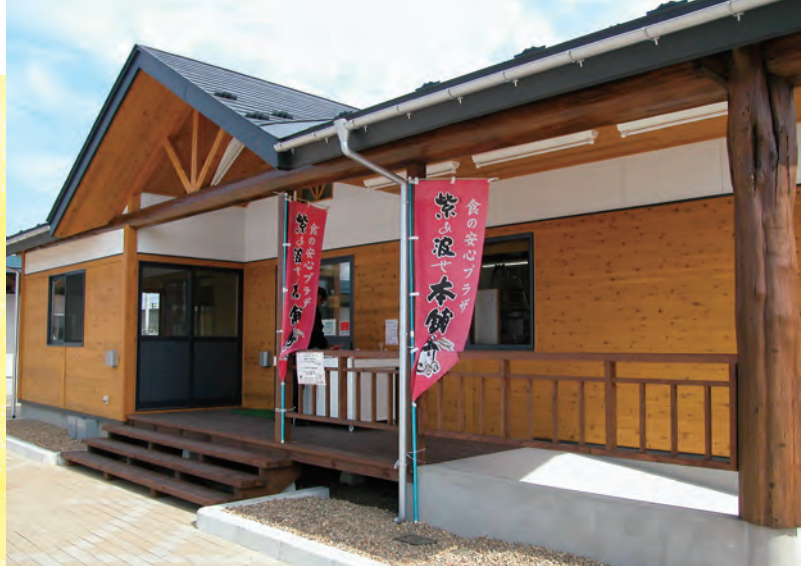
虹の保育園火災の被害木材が建物に使われています。
