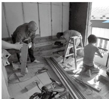
床の表面を取り外し、断熱性の高い断熱材を敷き詰め、天然の無垢材を使ったフローリングに交換。壁にも断熱材を追加し、木の温もりあふれるおしゃれな壁が完成。また、窓から熱が逃げることを防ぐため、軽くて手頃なパネル材を使用した内窓を取り付け、快適な部屋に変身!
