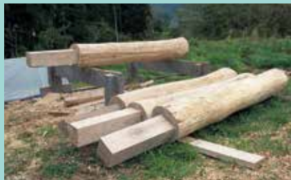
東屋の柱になったクリの木。複雑な形の「ほぞ」も、器具を使用することでより正確に、簡単に行えるそう。
