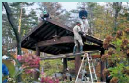
あじさい山で東屋を建てている様子(10月26日)。クリやマツ、スギなどが使用されており、どっしりとした安定感と独特の温もりが感じられる。
