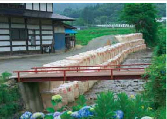
土のうで応急処置している繫川（赤沢地区） （7月4日の様子）
