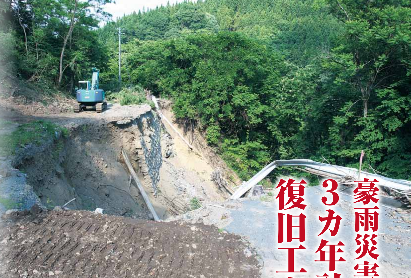
志和稲荷神社から山王海ダムに向かう山王海2号線。 壊れたガードレールをつなげたラインまで、本来は道路だった。(6月26日の様子)
