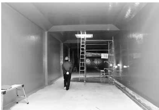
古館配水池の貯水槽内部
