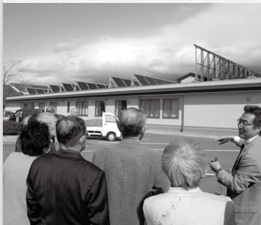
特養老人ホームにいやま荘の屋根に設置された 太陽光発電システム
