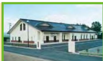
上平沢地区 農業集落排水処理施設 (平沢地内・平成19年～)
