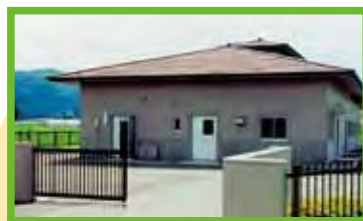
水分地区 農業集落排水処理施設 (宮手地内・平成9年～)
