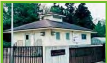
山王海地区 農業集落排水処理施設 (片寄地内・平成4年～)
