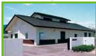
片寄地区 農業集落排水処理施設 (片寄地内・平成14年～)
