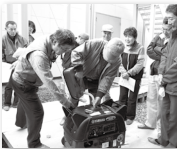
発電機の操作を確認
