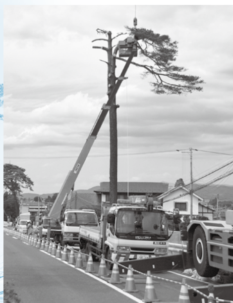
7月12日の伐採作業
