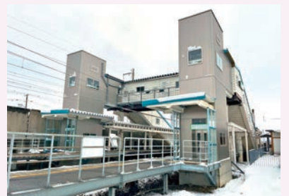
完成したエレベーター
