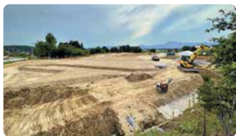
造成工事の様子
