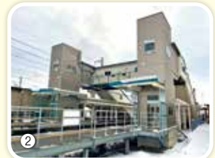
新設されたエレベーター
